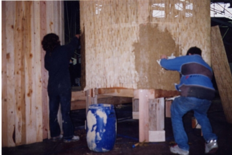
Photo 3 : Habillage des cabanes en canisses de roseau enduites de terre ou en bardeau de cèdre
